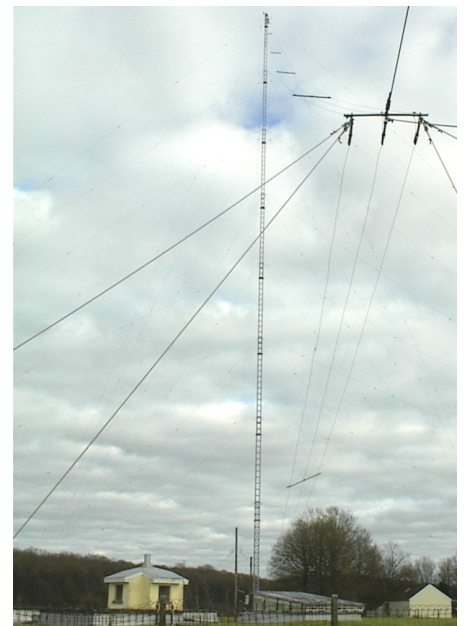
Fig.3-3. Dourbes ionosonde’s transmit antenna ( Jodogne , 1974): multiwire design, height: 40 m, orientation: NE-SW.
